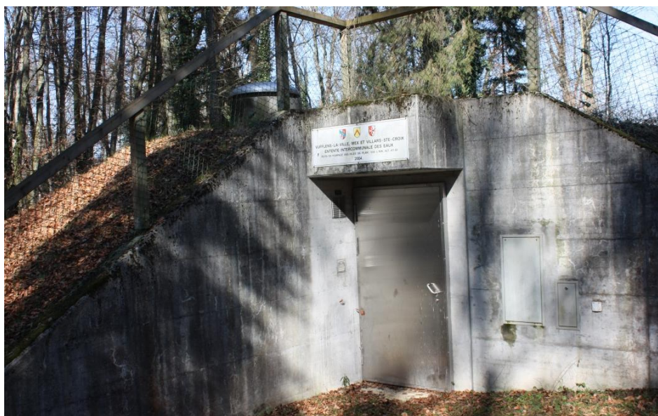
Station de pompage de l'EIEVMV
