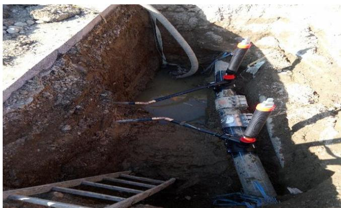
Compte tenu du danger que représentait le soulèvement, lors de chaque orage important, du couvercle d'une chambre d'eaux claires du chemin des Mainnesses, nous avons remplacé, par forage dirigé, la conduite d'eaux claires entre le chemin des Mainnesses et le chemin des Grands-Champs. D'un diamètre supérieur, cette conduite en polyéthylène assure une évacuation des eaux pluviales nettement accrue.
